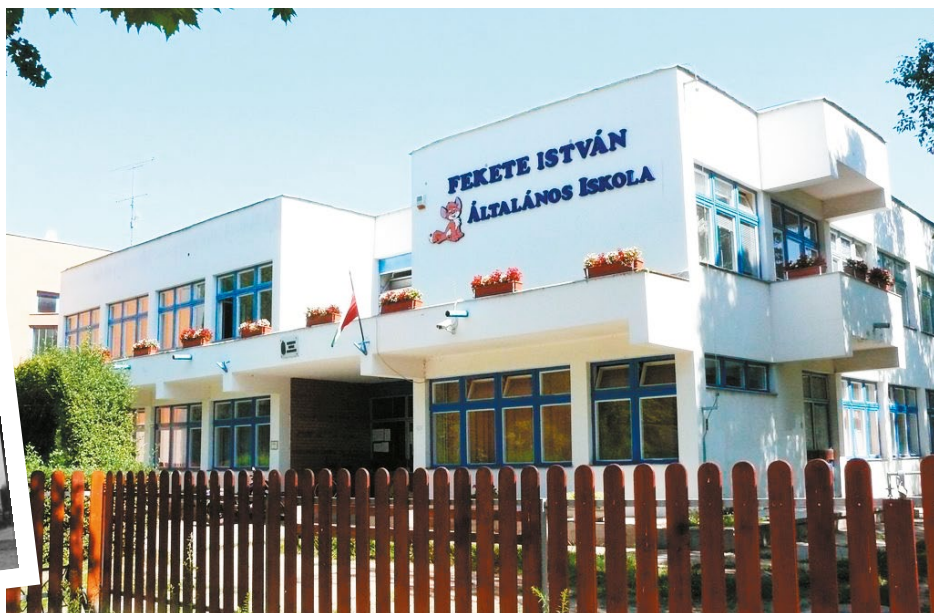
... és a felújított intézmény bejárata
