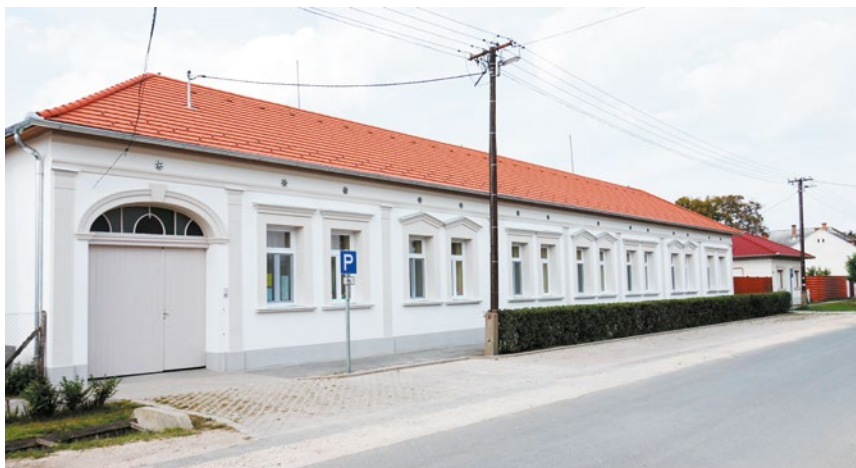
2014 nyarán önkormányzati támogatásból a Szent Lajos utcai óvoda külső felújítása történt meg
